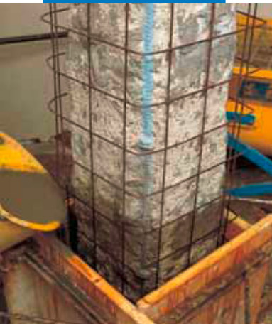
Turnare în cofraj
