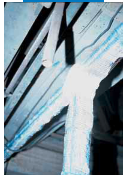
Deteriorarea structurii din beton
